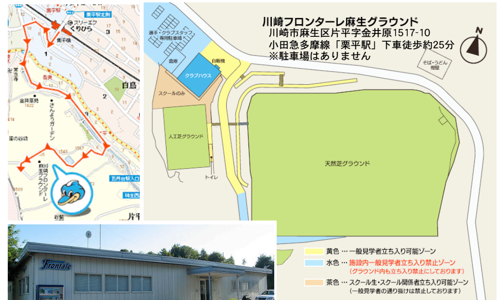
←太陽熱温水器を屋根に設置する予定のクラブハウス
