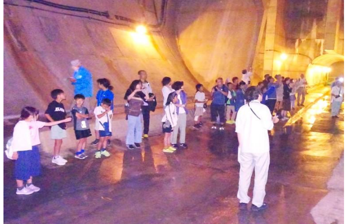
恩廻公園調節池
