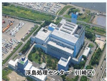
■市内には現在、4か所の一般廃棄物焼却施設があり、市内一般家庭のごみ処理を支えています。その中でも、最大の処理能力を持つ浮島処理センターは、**処理能力900t/d、発電能力12,500kW**を擁しています。
